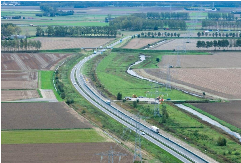
Vooruitlopen op nieuwe mogelijkheden: verbreding van de N62 (Bron: Beeldbank Rijkswaterstaat, http://beeldbank.rws.nl )
