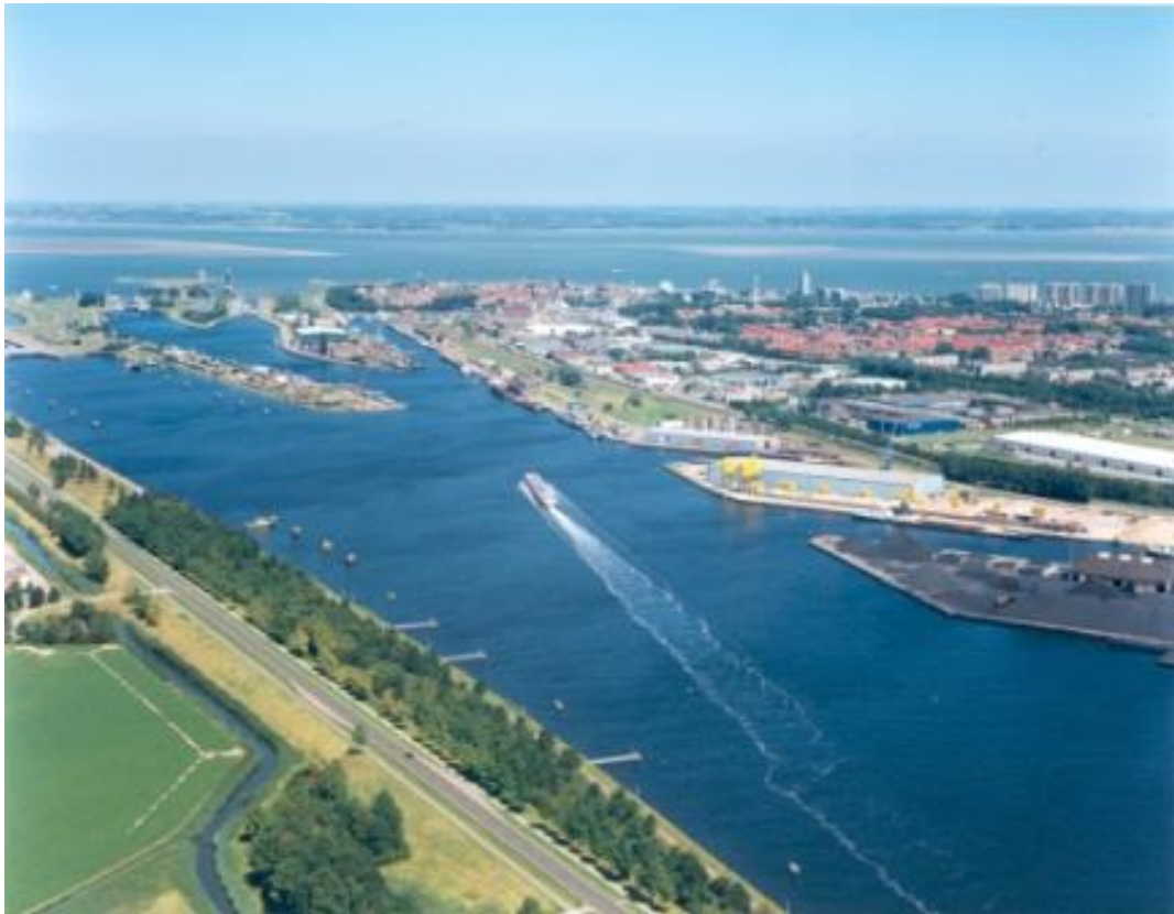
Terneuzen, Westerschelde en Kanaal Gent-Terneuzen (Bron: Beeldbank Rijkswaterstaat, http://beeldbank.rws.nl )
